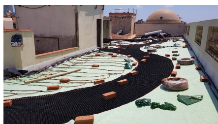
Die Drän- und Wasserspeicherelemente Floradrain® FD 40 liegen vollflächig auf dem Dach und in den Pflanzbereichen ist zur Unterflurbewässerung das Aquafleece® AF 300 mit seinen Tropfschläuchen verlegt.
