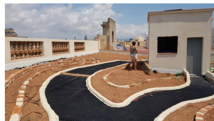
Sowohl das ZinCo-Dachgartensubstrat aus recyceltem Tonziegelsplitt als auch der Kalkmörtel für die Abgrenzungen sind nachhaltige Naturprodukte.
